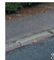
La voirie ne montre pas de défaut particulier quant à son revêtement. Un bitume uniforme recouvre les espaces de circulation automobile, sans irrégularités marquantes (1). Il présente simplement quelques craquelures, insignifiantes lors du passage en voiture ou en vélo. S'agissant d'un revêtement non récent, il n'est pas insonorisé.
